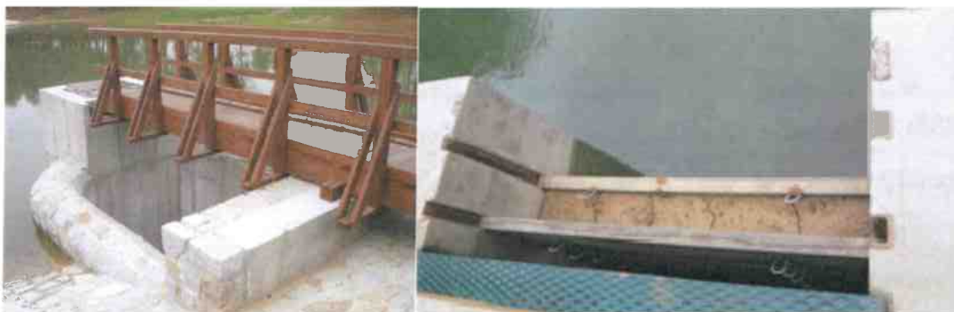
Obr.č.6. Pohľad na drevenú lávku nad združeným objektom a hradidlové dosky s ílom.
