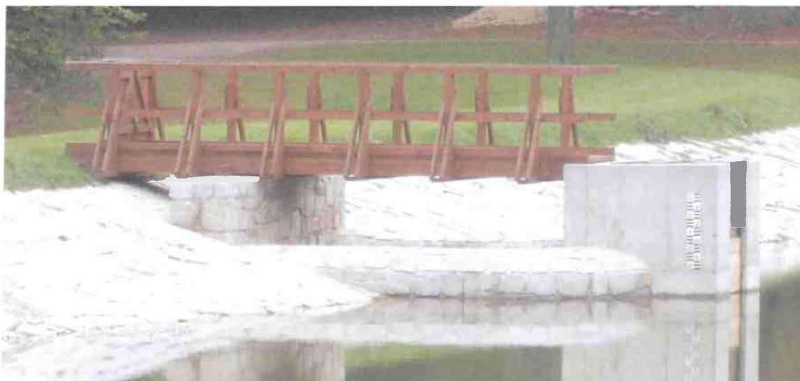
Obr.č.5. Pohľad na združený výpustný objekt s vodomernou latou a dreveným zábradlím. .
